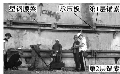
图 7 金府站深基坑内施作完成的预应力锚索
